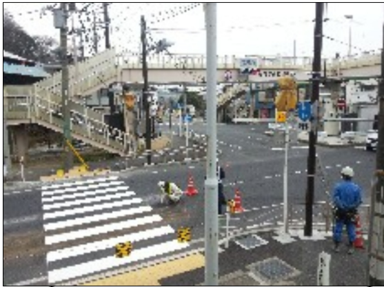
3月16日、設置工事を確認に現地へ
